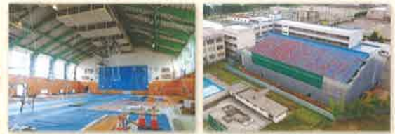
▲ 体育館改修工事
